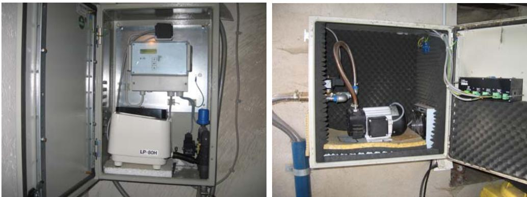
Bild 9.1 Nicht isolierter Steuerschrank (links) und lärmgeminderter Steuerschrank (rechts)
