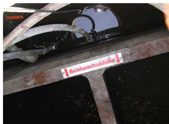
Bild 4.13 Durch Schlammentsorger entleertes Vorklärbecken nach zwei Wochen erneuter Zuleitung (links, Übertritt mit Pfeil gekennzeichnet) und Kennzeichnung der zu entleerenden Schlammspeicher
