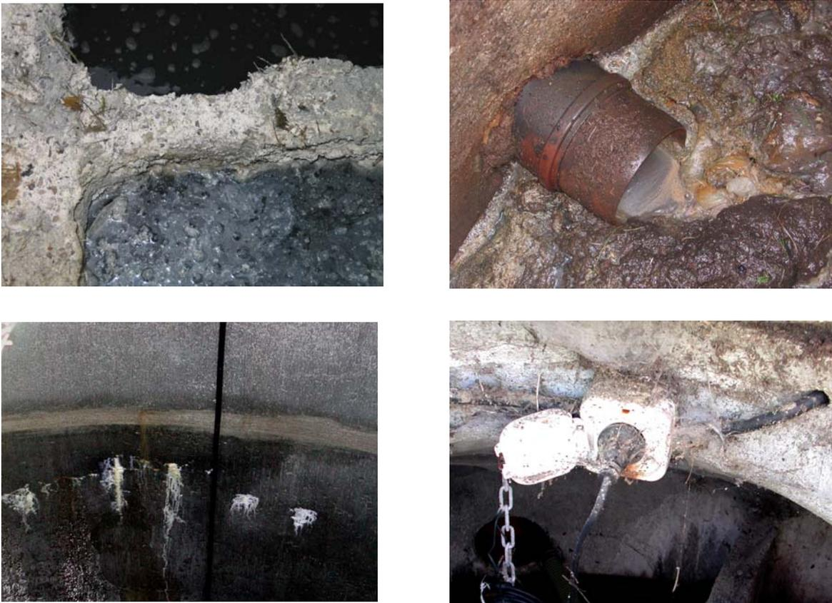
Bild 4.12 Einbaumängel wie fehlende Querlüftung (links oben, Betonkorrosion), zu tief liegende Zulaufleitungen (rechts oben), Undichtigkeiten (links unten) und offene Elektrik (rechts unten)
